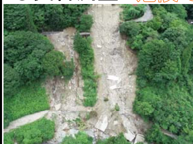
山腹崩壊による災害測量（UAVによる写真撮影）
